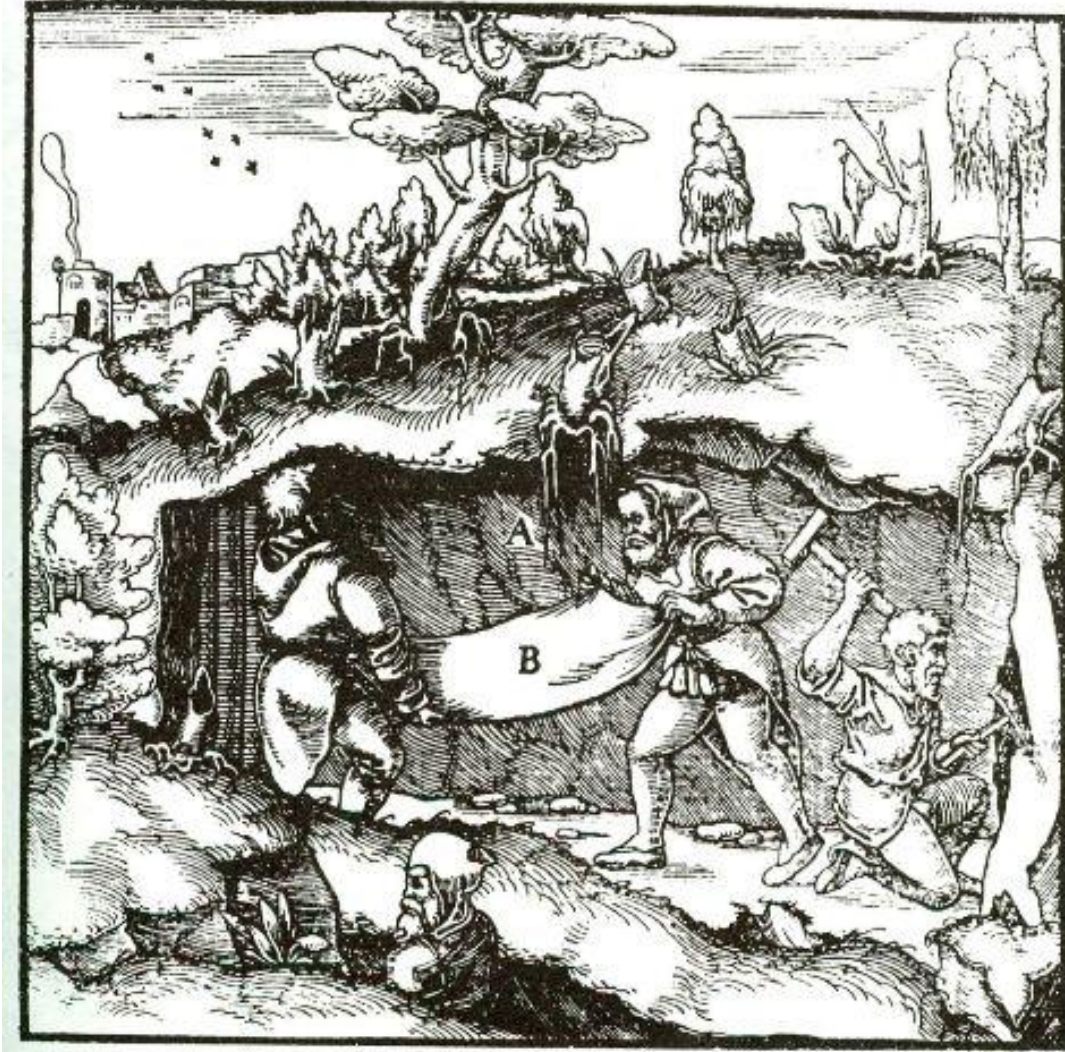
Şekil 1 : Maden galerisi girişinde bir bez veya post parçası ile galerilerde çalışanlara dışarıdan taze hava vermeye çalışan iki işçi (esir , köle, mahkûm vb.) Georgius Agricola, De re metallica libri XII , Basel 1556, S. 170.
