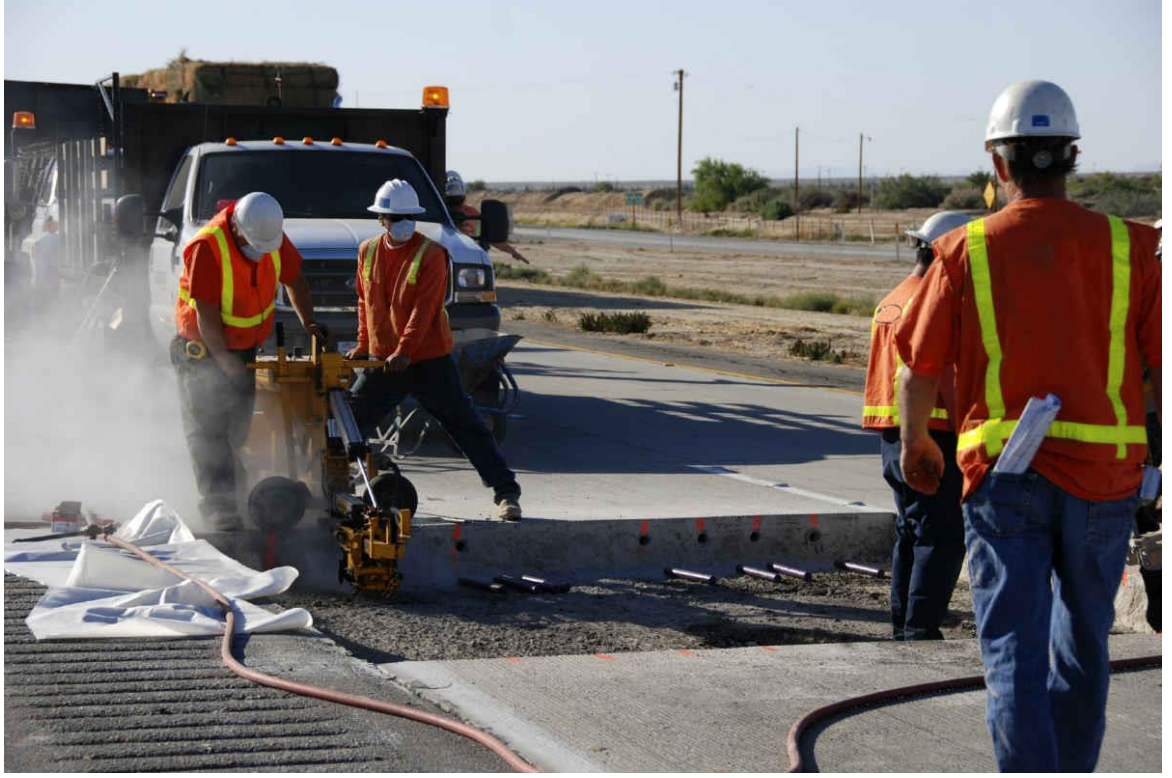
Resim 21- El ve kol titreşimi oluşturan ve meslek hastalığına neden olabilecek çalışma örneği
